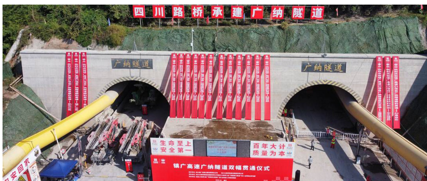
10月15日上午,广纳隧道双幅贯通。
