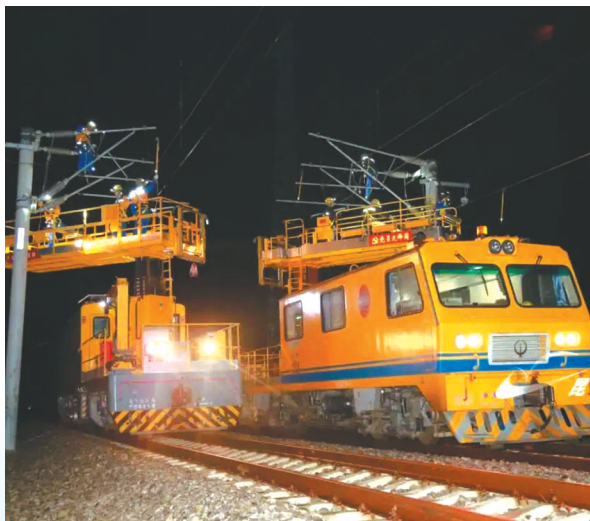
高铁接触网夜间检修。图据昆明铁路微信公众号
