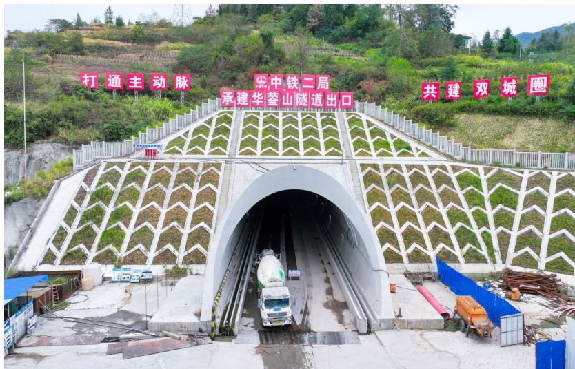
成达万高铁华蓥山隧道出口贯通
