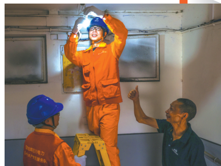
▲ 高新连心桥党员服务队排查老旧小区供电隐患并将小区楼道路灯更换为节能灯，获居民点赞。
