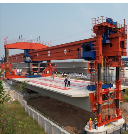
成渝中线高铁重庆段首孔箱梁架现场。重庆市铜梁区融媒体中心供图
