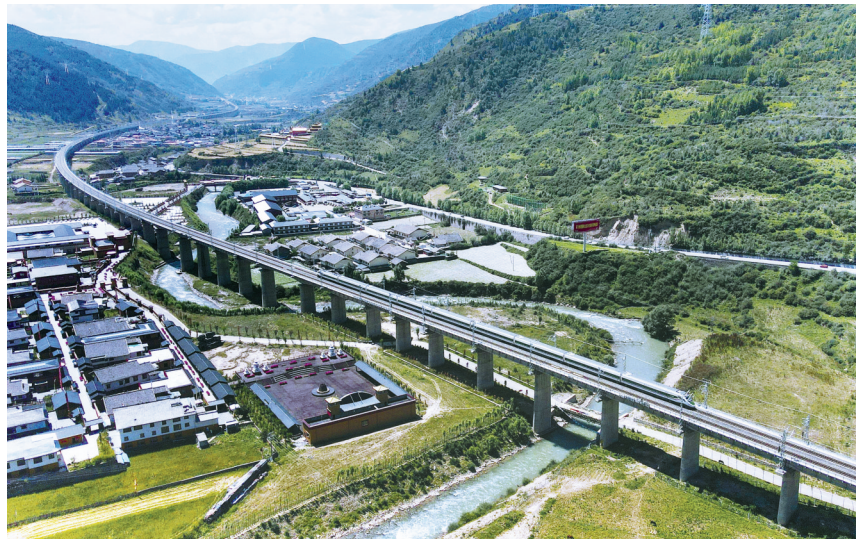
试运行列车在川青铁路镇江关至黄胜关段开行。成兰铁路公司供图
