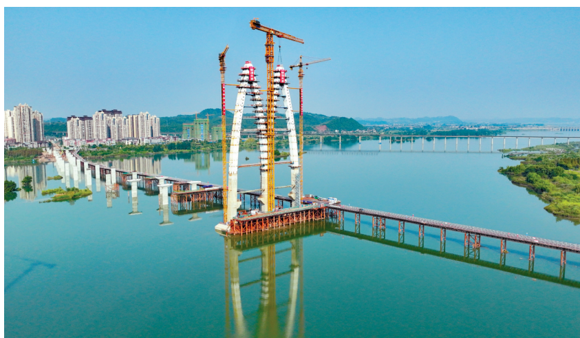
遂宁涪江六桥主塔顺利封顶。蜀道集团供图
