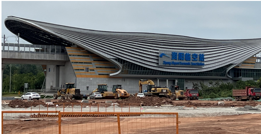
施工接近尾声的资阳临空站。
