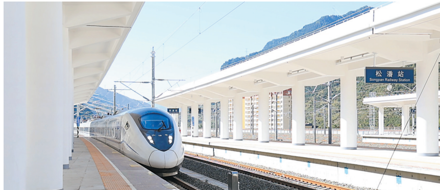
运行试验列车抵达松潘站。成兰铁路公司供图
