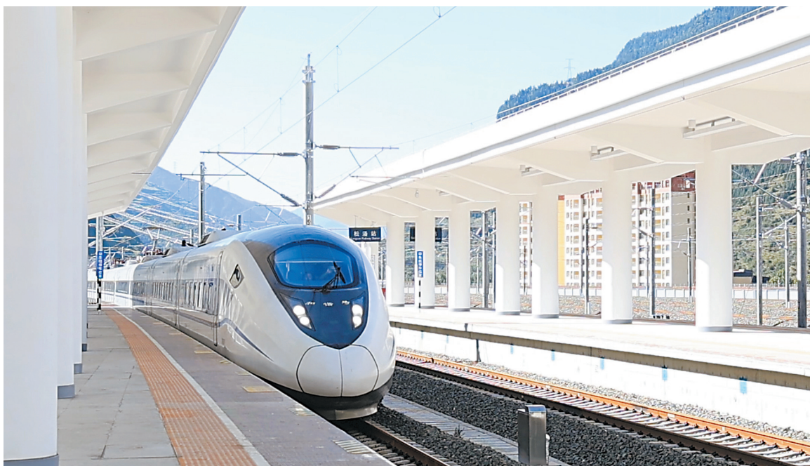
运行试验列车抵达松潘站。成兰铁路公司供图
