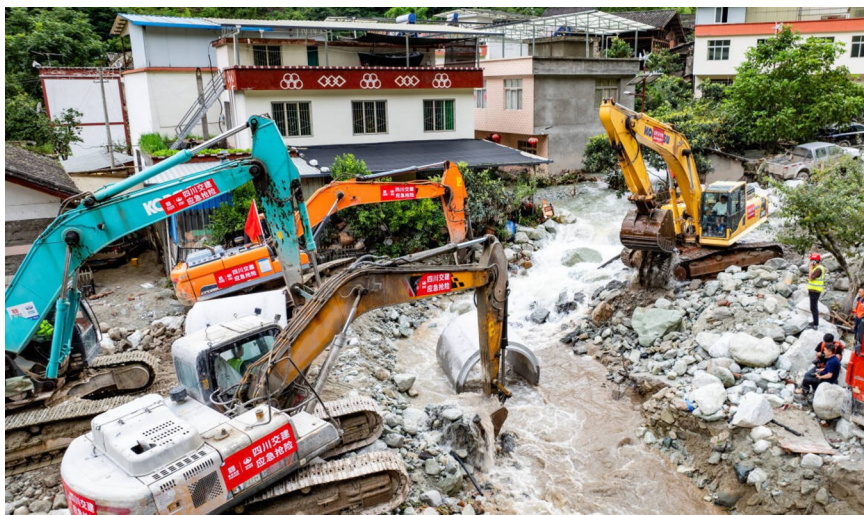
抢险人员在抢通国道318应急通道。图据川观新闻
