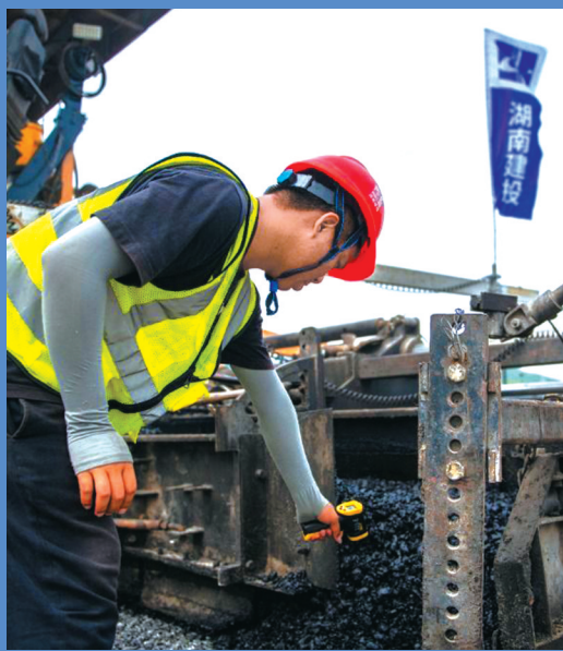
2023年7月25日，在湖南衡永高速公路工程施工现场，工人在测量沥青温度。 新华社发
