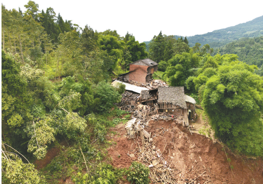
山体滑坡导致村民房屋被撕裂。达州市达川区融媒体中心供图
