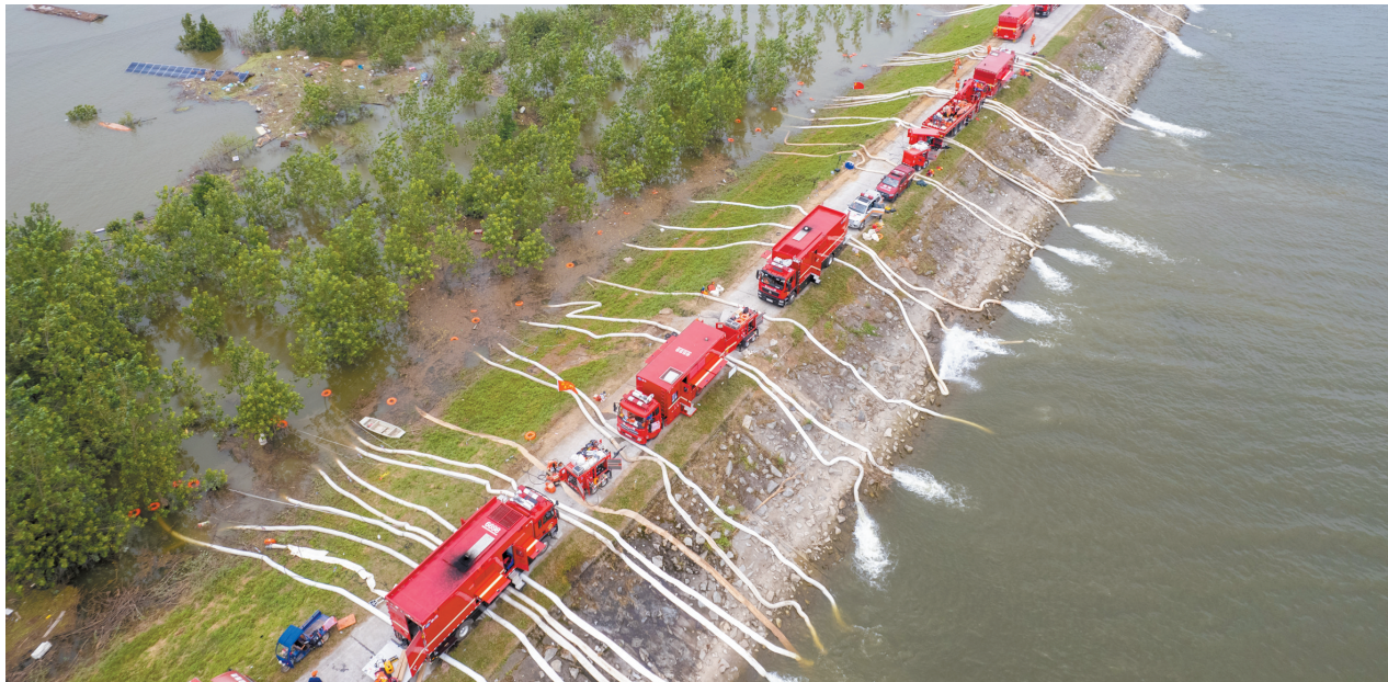
7月9日，在湖南华容县团洲垸洞庭湖大堤，排涝作业在进行中。新华社发
