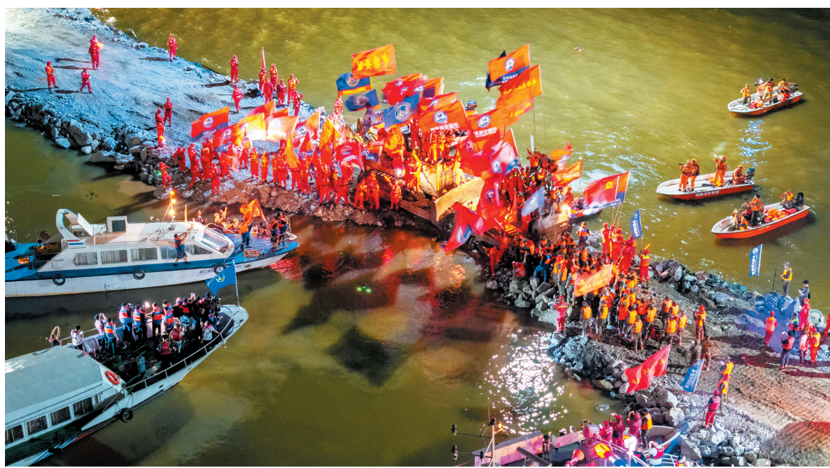
这是7月8日晚拍摄的团洲垸洞庭湖大堤决口封堵现场(无人机照片)。新华社发
