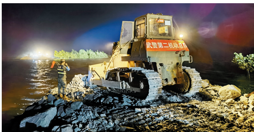
7月7日凌晨,在湖南省岳阳市华容县团洲垸洞庭湖一线堤防决口处,武警部队官兵操纵工程机械封堵决口。新华社发
