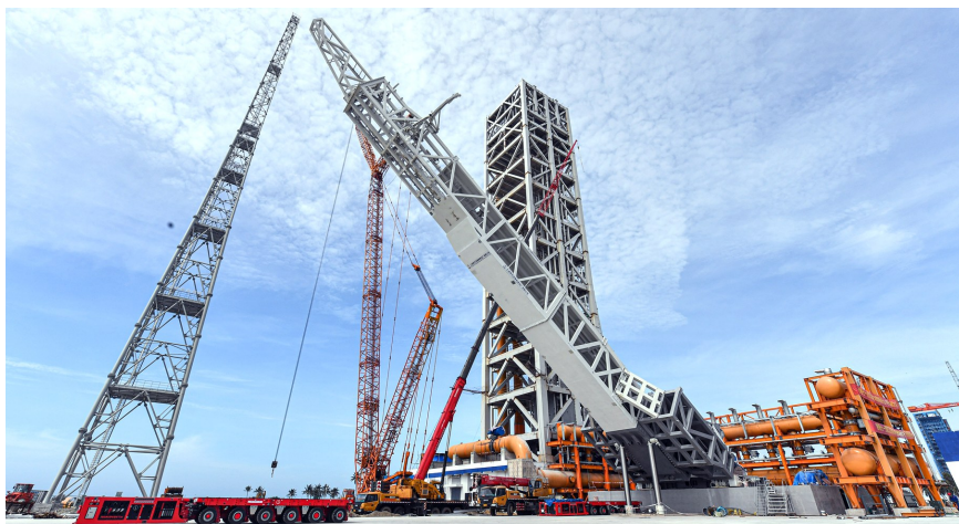
6月30日在海南商业航天发射场二号发射工位拍摄的模拟起竖。新华社发
