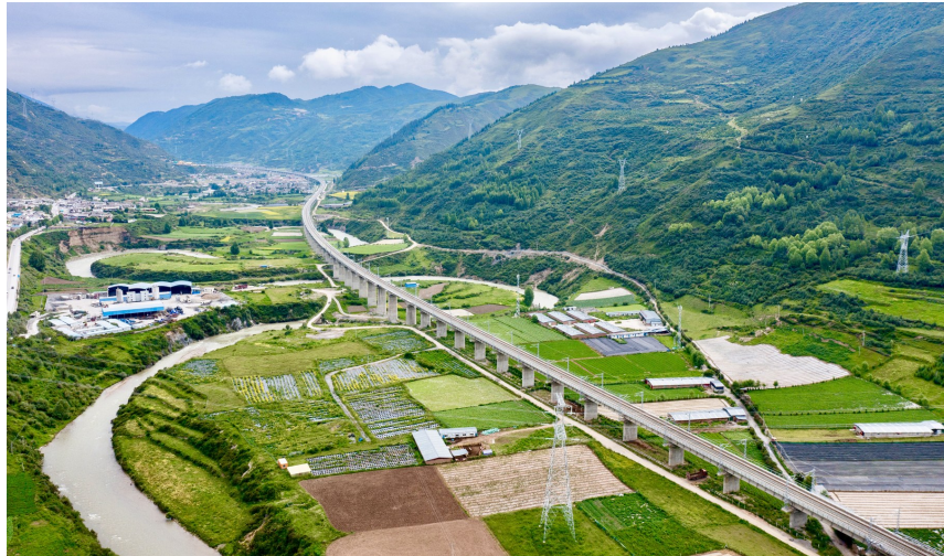
川青铁路镇江关至黄胜关段完成铺轨。成兰铁路公司供图
