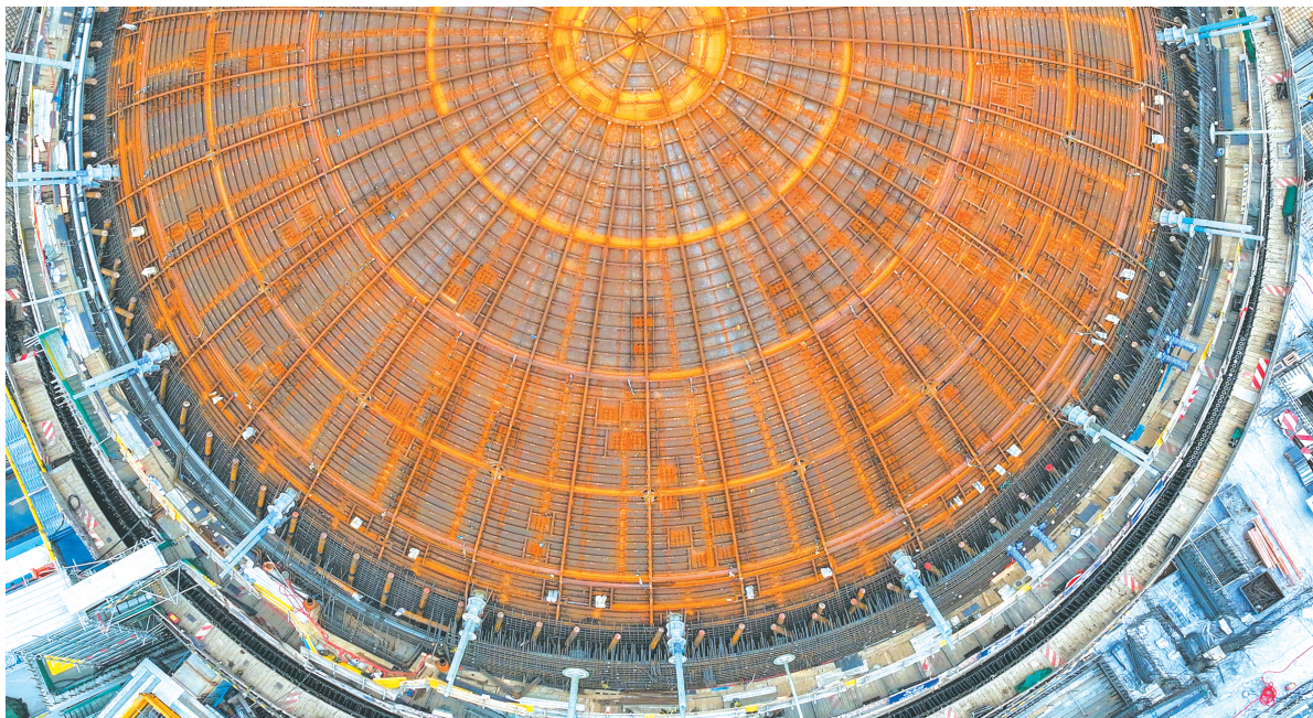
2024年6月19日拍摄的位于江苏连云港的田湾核电基地8号机组工程施工现场(无人机照片)。
