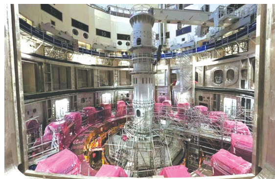
国际热核聚变实验反应堆(ITER)被誉为世界最大人造太阳。图为2023年11月23日,在ITER建设现场拍摄的正在安装的托卡马克装置。
