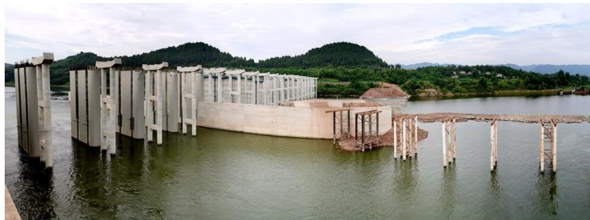
泄洪冲沙闸和施工钢栈桥墩。
