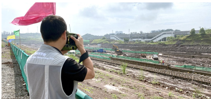
采访团成员拍摄正在建设中的内江国际物流港铁路专用线项目。
