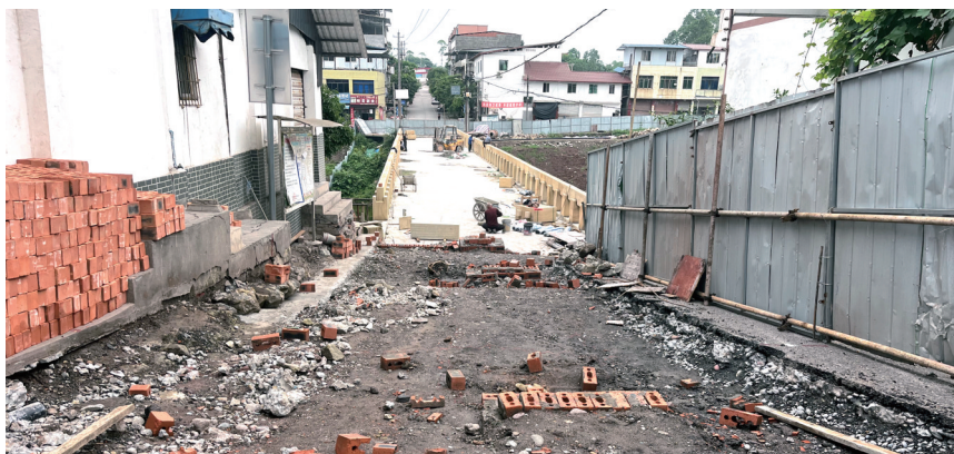
工人们正在桥上施工。杜卓滨 摄
