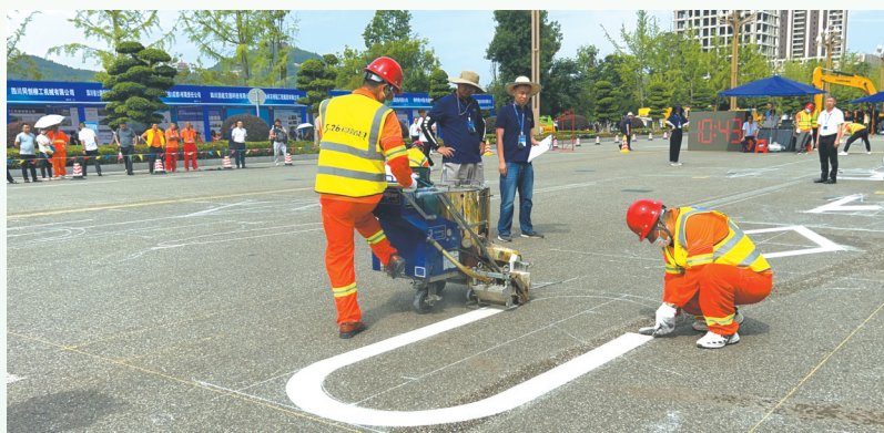
5月26日,四川省交通运输厅公路局举办的路面热熔标线施工比赛现场。夜晚在车灯照射下,高速公路上的路面热熔标线会反光。曹菲摄
