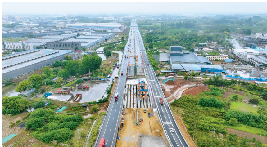
成乐高速扩容二期项目青龙段建设现场。受访者供图
