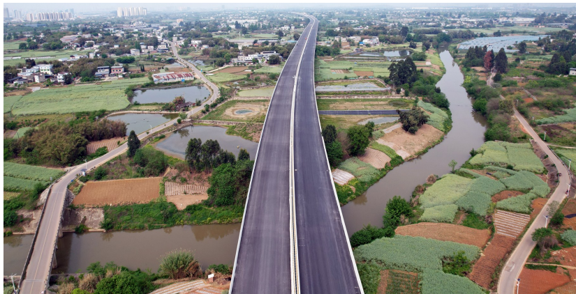
成南高速扩容项目成都入城复线段。交通运输厅供图
