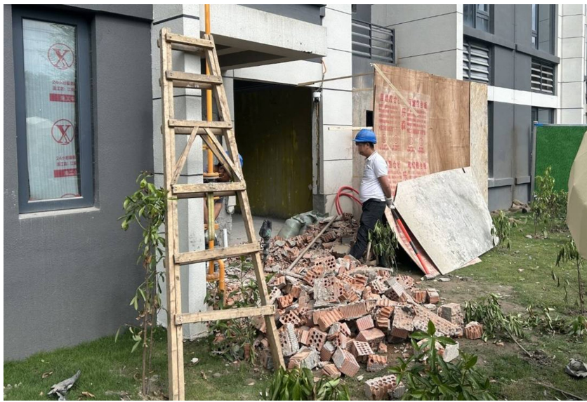
小区部分违章搭建正被拆除。
