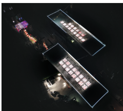
转体施工现场。蜀道集团供图
