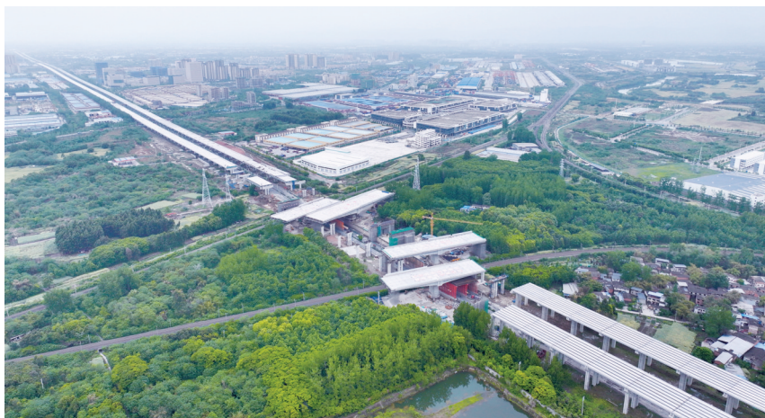
4座桥梁上跨成都北环线铁路枢纽。蜀道集团供图
