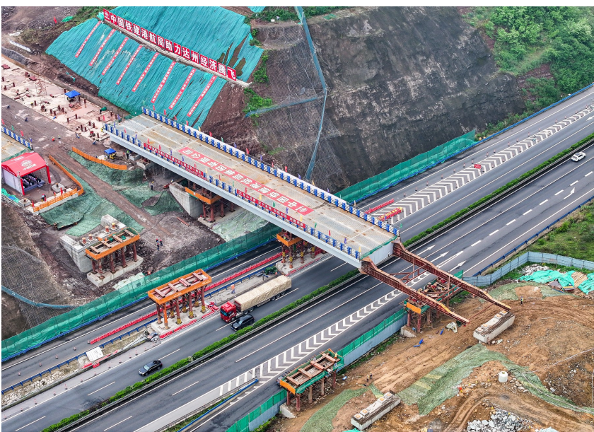
总重量接近700吨的达州金河大道一标段1号大桥左幅钢箱梁跨越高速公路。黄江涛摄
