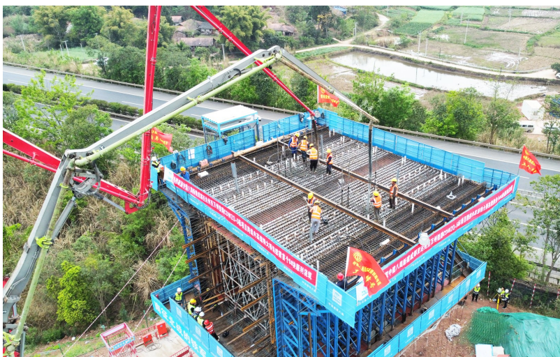
连续梁“0号”块“封顶”。中建八局供图
