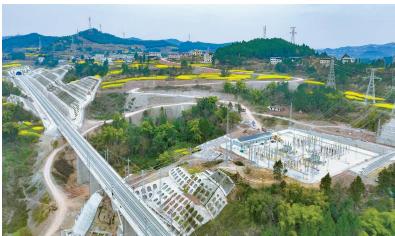
仪陇牵引变电所是巴南高铁全线4颗“心脏”之一。蜀道集团供图
