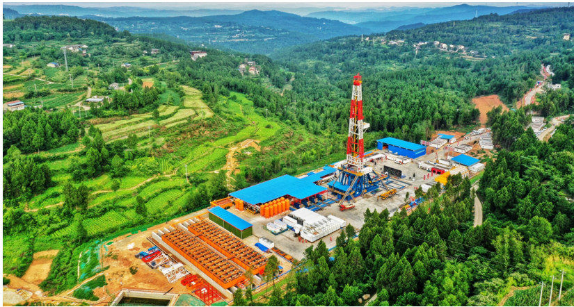
位于广元市剑阁县的深地川科1井。
