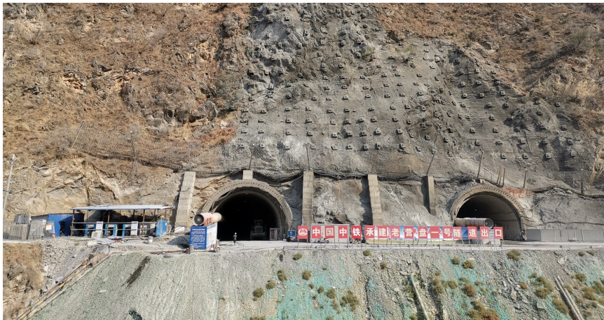
老营盘一号隧道出口开在陡坡上。
