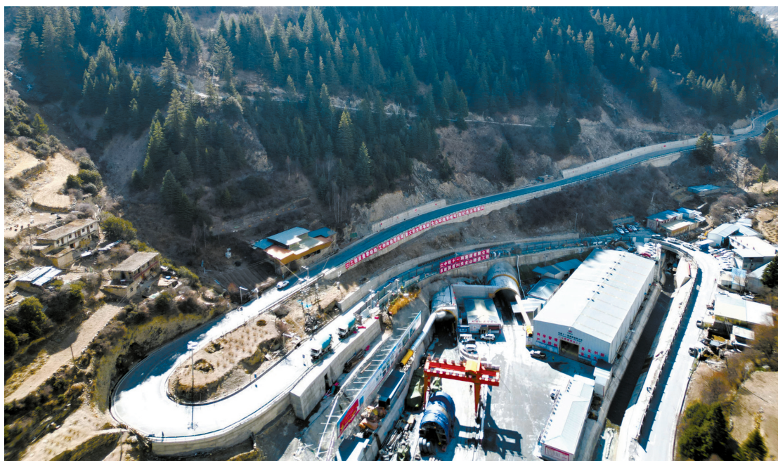
国道351夹金山隧道小金端航拍画面。
