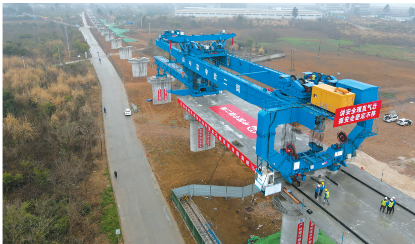
架梁现场。长江沿岸铁路集团四川有限公司供图
