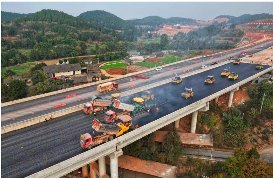
2月19日,G5京昆高速公路绵阳至成都段扩容项目LM2标段正在进行沥青铺设施工。 图据新华社客户端
