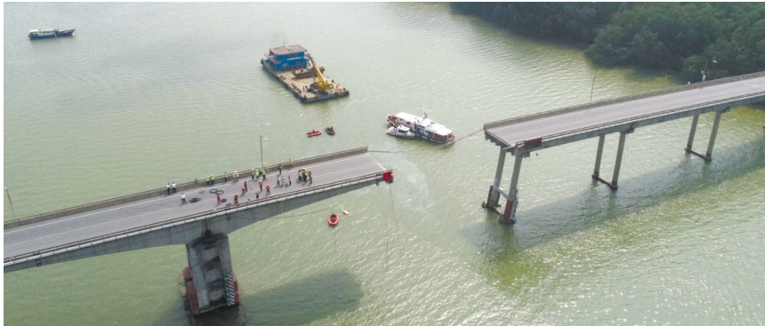
2月22日,救援人员在沥心沙大桥事故现场进行救援。新华社发
