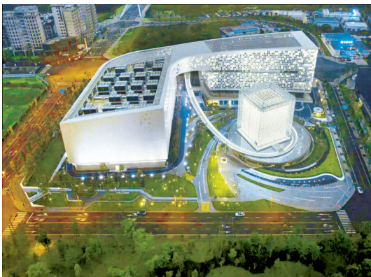
成都超算中心。图据中建西南院
