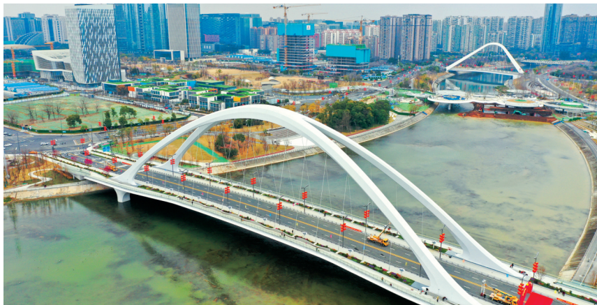
俯瞰成都锦尚大桥。中国五冶集团供图
