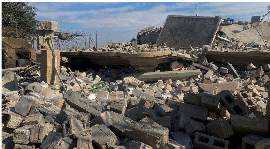
这是2月3日在伊拉克加伊姆拍摄的美军空袭后的建筑废墟。新华社发
