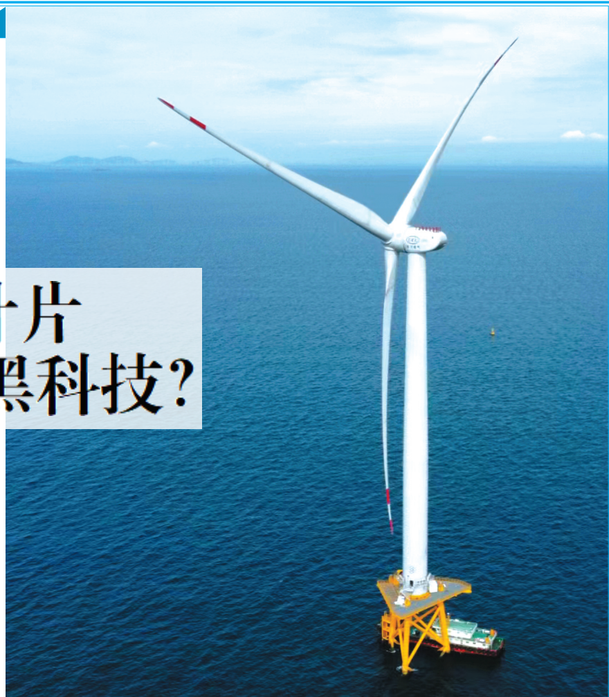
126米叶片风电机组矗立在海面上。东方电气供图
