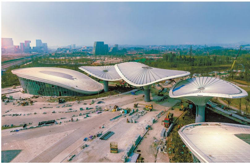
成都世园会综合服务馆建设现场。柴枫桔 摄
