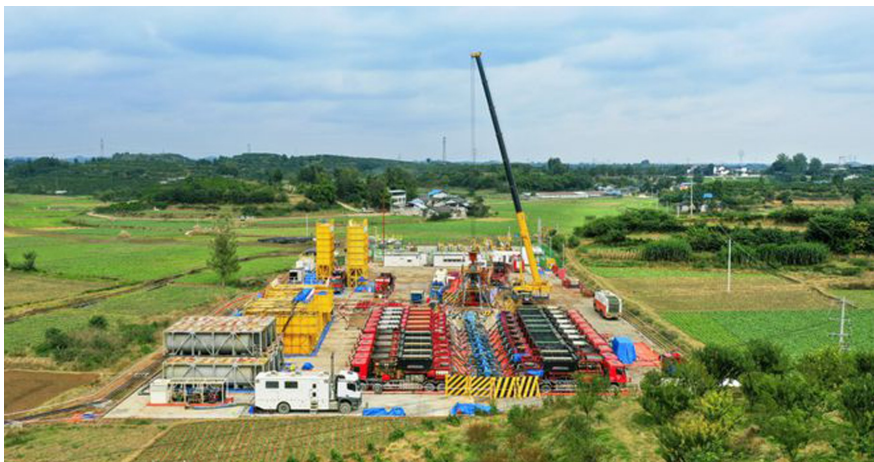
合兴场气田新盛201平台施工现场。刘淑石 摄
