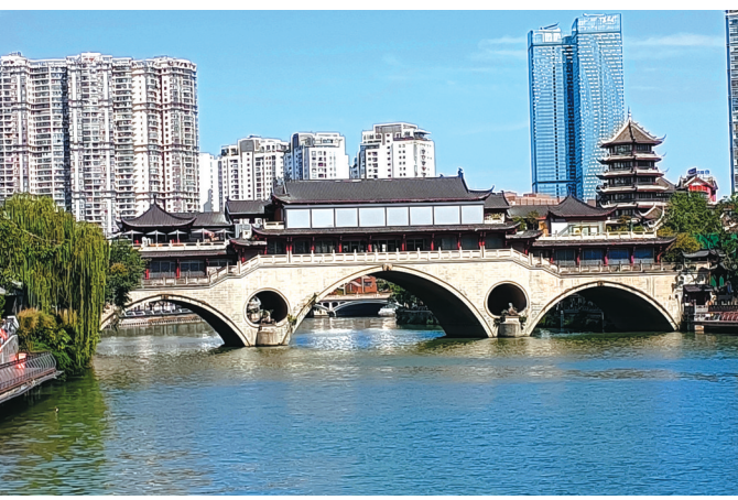
今日位于锦江上的安顺廊桥。张海摄
