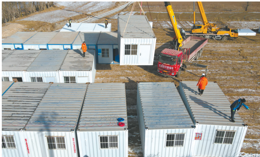
12月21日,在积石山县大河家镇梅坡村,施工人员搭建活动板房。新华社发
