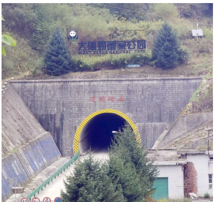
108国道秦岭隧道口。
