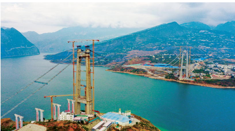
卡哈洛金沙江大桥。蜀道集团供图
