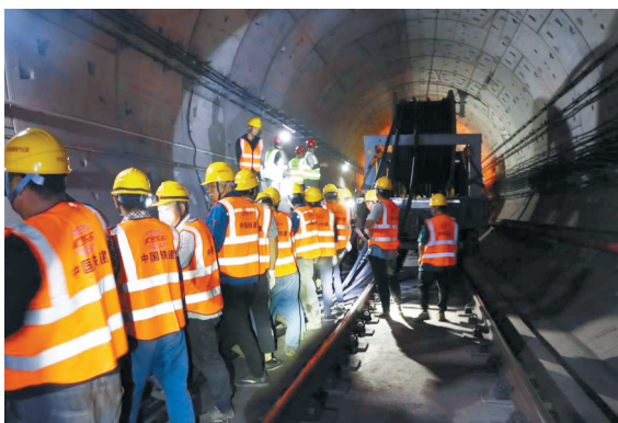
成都轨道交通18号线三期建设者进行电缆敷设。成都轨道集团供图
