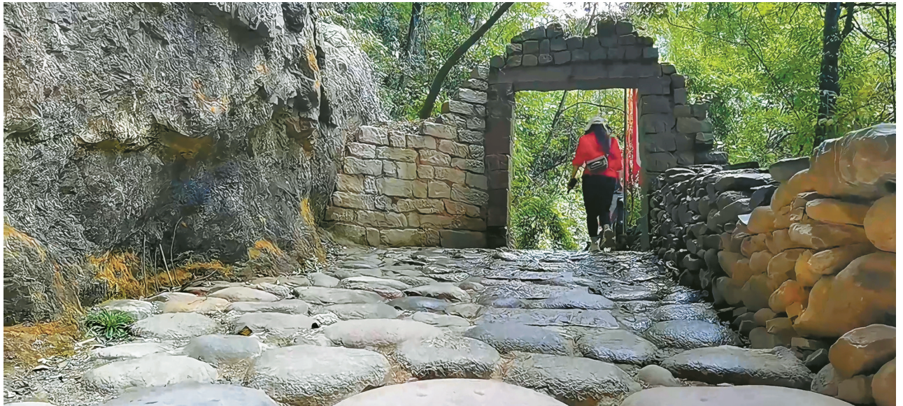
后人修葺过的米仓古道路段。
