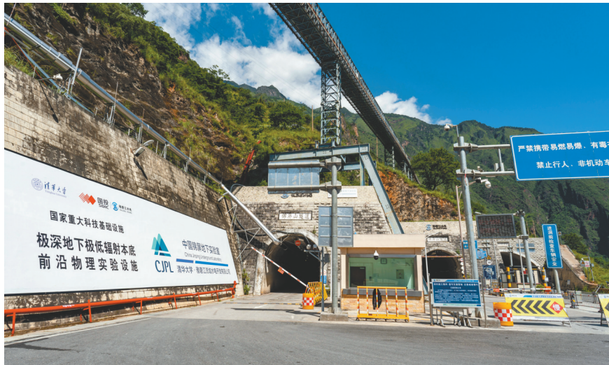
中国锦屏地下实验室位于凉山州锦屏山下2400米处,图为锦屏山交通隧道东端入口。
