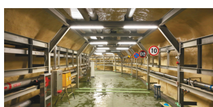
锦屏大设施辅助隧道。
