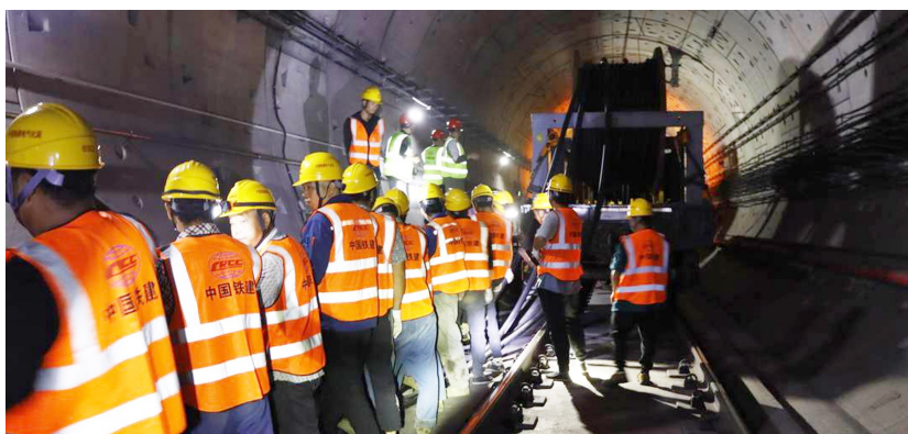
成都地铁18号线三期建设者进行电缆敷设。图片由成都地铁提供
